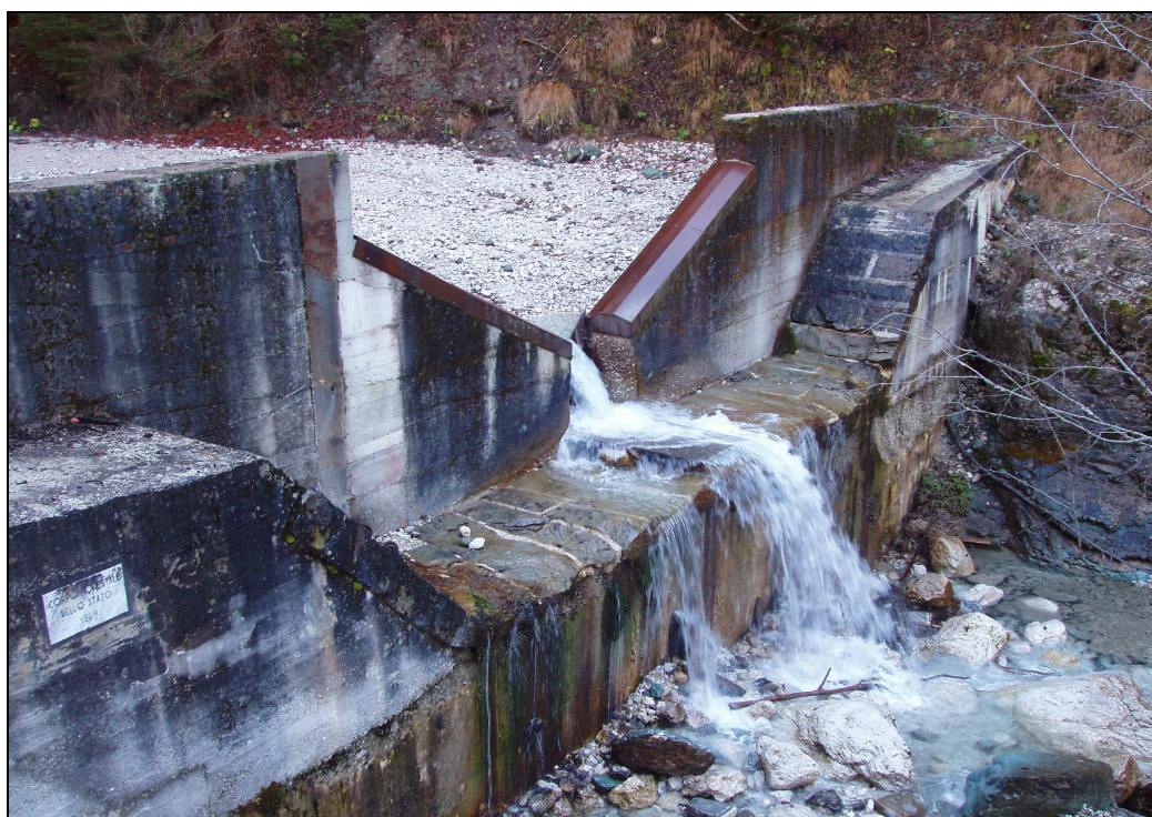
Fig. 25 - Stazione di misura dei deflussi, a quota 1096 m s.l.m., attiva dal 1983 al 2001. Stato attuale della briglia di consolidamento e dello stramazzo triangolare per la registrazione dei livelli idrometrici
